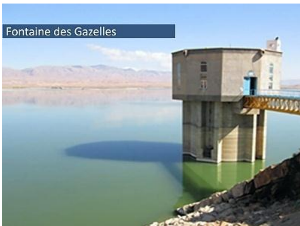
Figure (11) : Barrage Fontaine des Gazelles (ANBT,2004)
