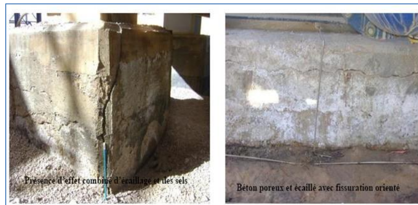
Figure IV.8: La Lixiviation et l'écaillage
