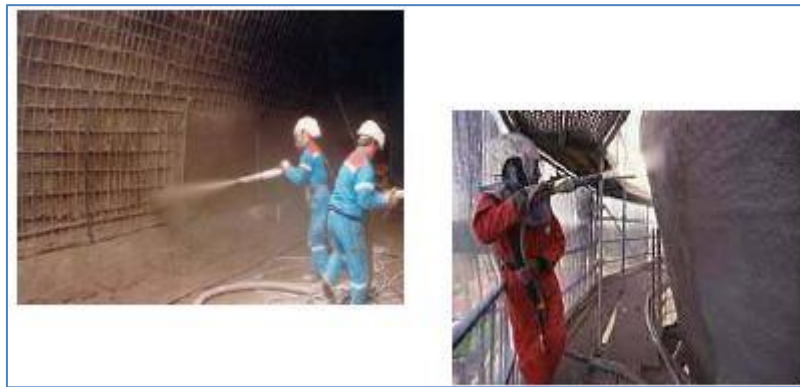
Figure III.2: Renforcement au moyen de béton projeté.
