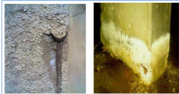
Figure I.3. attaques sulfatiques.
