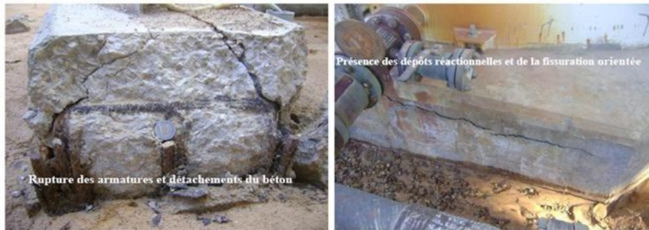
Figure IV.7: Les Alkali-réaction.
