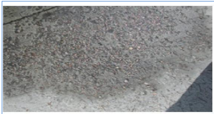
Figure I.6. Dégradation due aux sels de déverglaçage.
