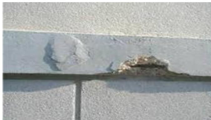
Figure I.19. Epaufure dans construction.
