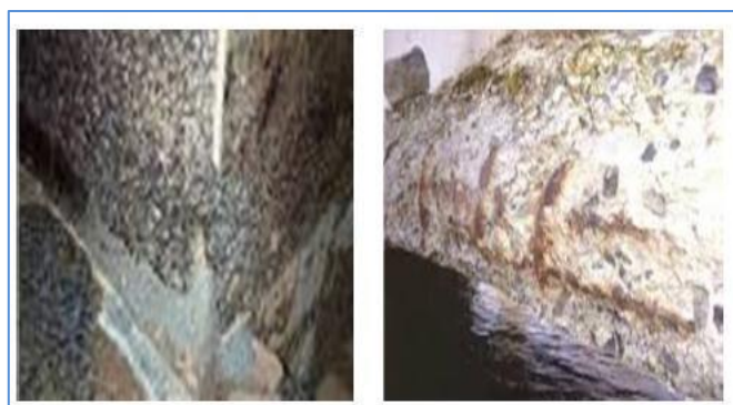
Figure I.4. Attaques acides.
