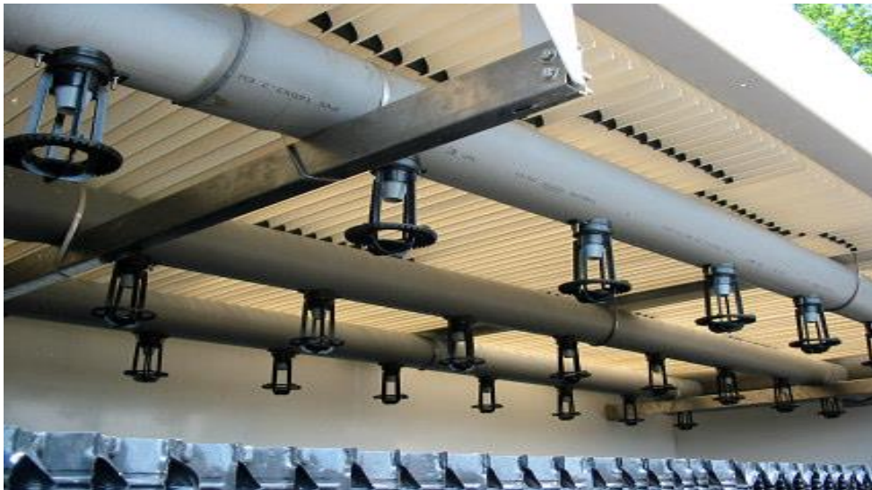
Fig.II.11 : Système de dispersion du fluide à refroidir [74]
