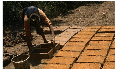
Figure I-10 : Moulage et séchage des blocs adobes
