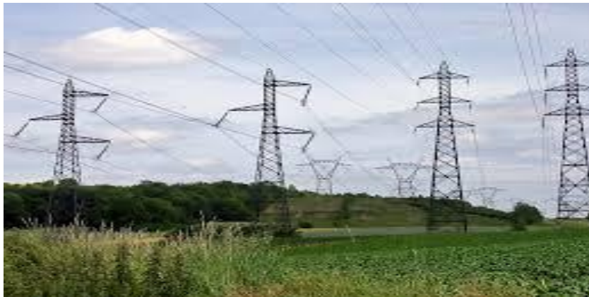
Figure(I.1) : Les lignes électriques
