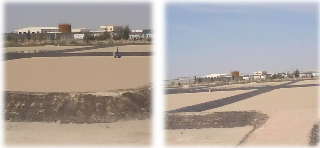
Figure 14: Lit de séchage des boues.
