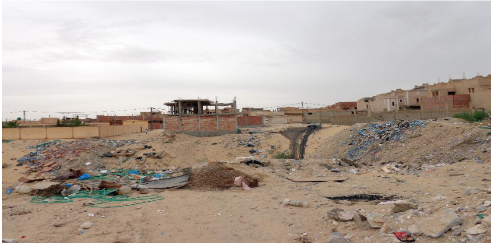
Photo 3 : Transformation d'un Ghout en décharge sauvage (KADRI, 2013).
