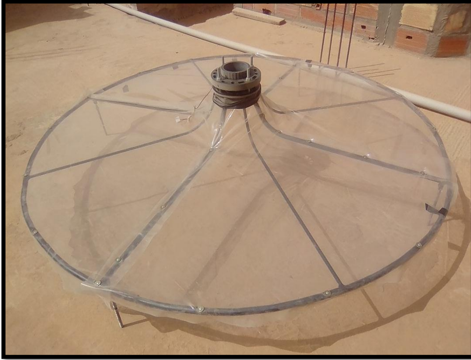
الشكل(3-19): صورة تبين سقف المجمع الشفاف
