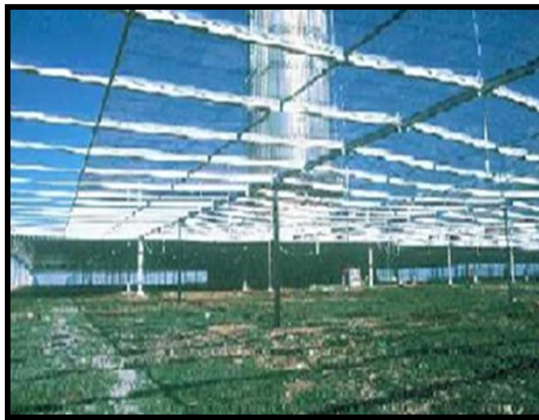
شكل(1-3): نموذج للمجمع الشمسي في المداخن الكبيرة من الداخل
