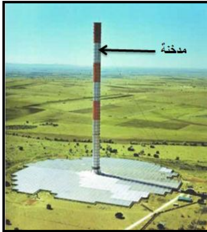
شكل(1-4): صورة توضح مدخنة (انبوب) في المدخنة الشمسية
