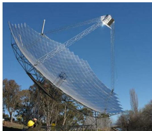
Figure I. 9 : à miroir parabolique développé par l'Université nationale australienne [73].
