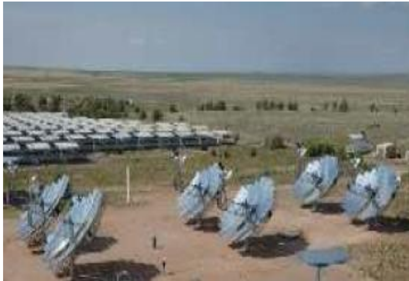
Figure I. 14 : Centrale solaire expérimentale de 6 concentrateurs solaires de type Parabole/Stirling SES à Albuquerque.
