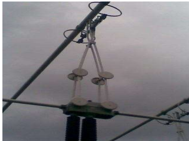
Figure II.5.4.2 Sectionneur fermé [12]
