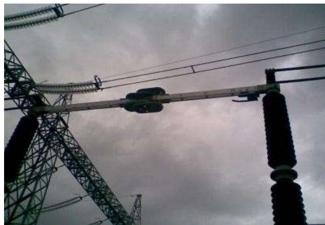
Figure II.5.4.2 Sectionneur ligne [12]
