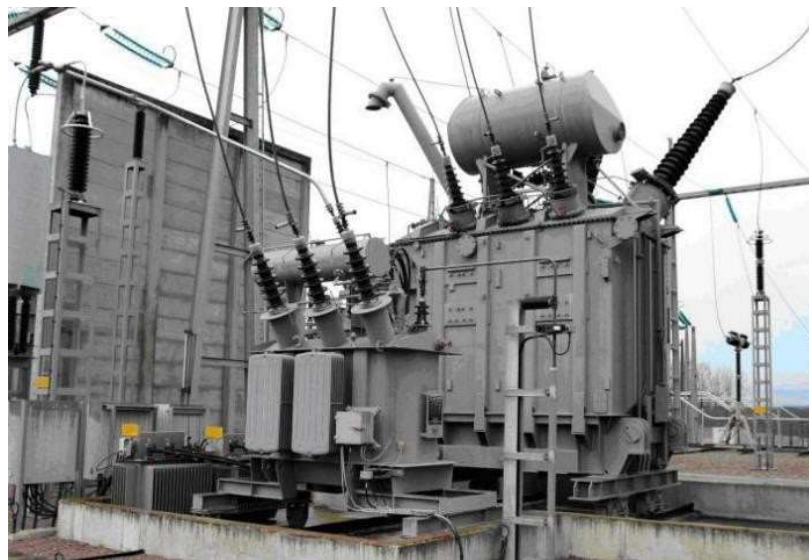
Figure II.5.3.1 Vue arrière d'un transformateur de puissance [8]
