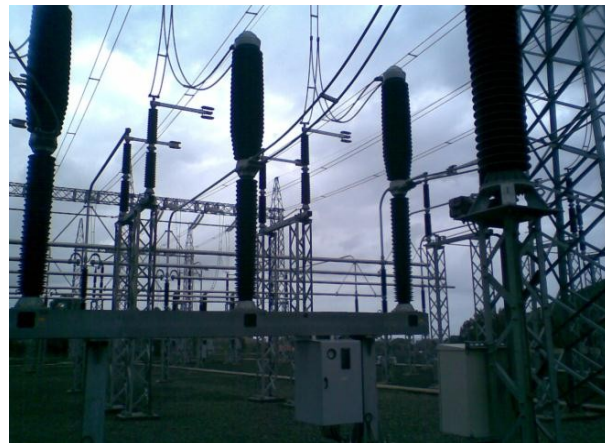
Figure II.5.2.b: disjoncteur 220Kv [8]
