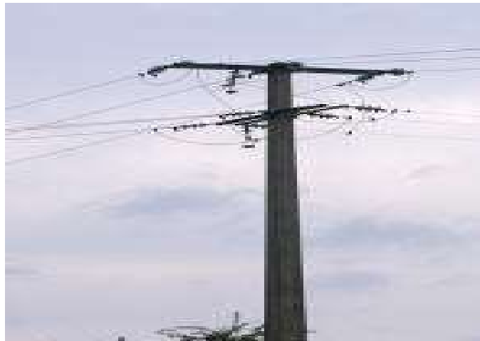
Figure I.8.2 Poteau en béton ligne 60 kV[5]
