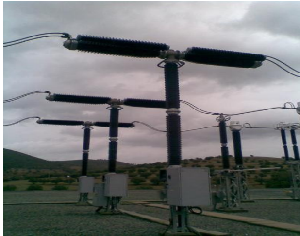
Figure II.5.2.a disjoncteur 400 Kv [8]
