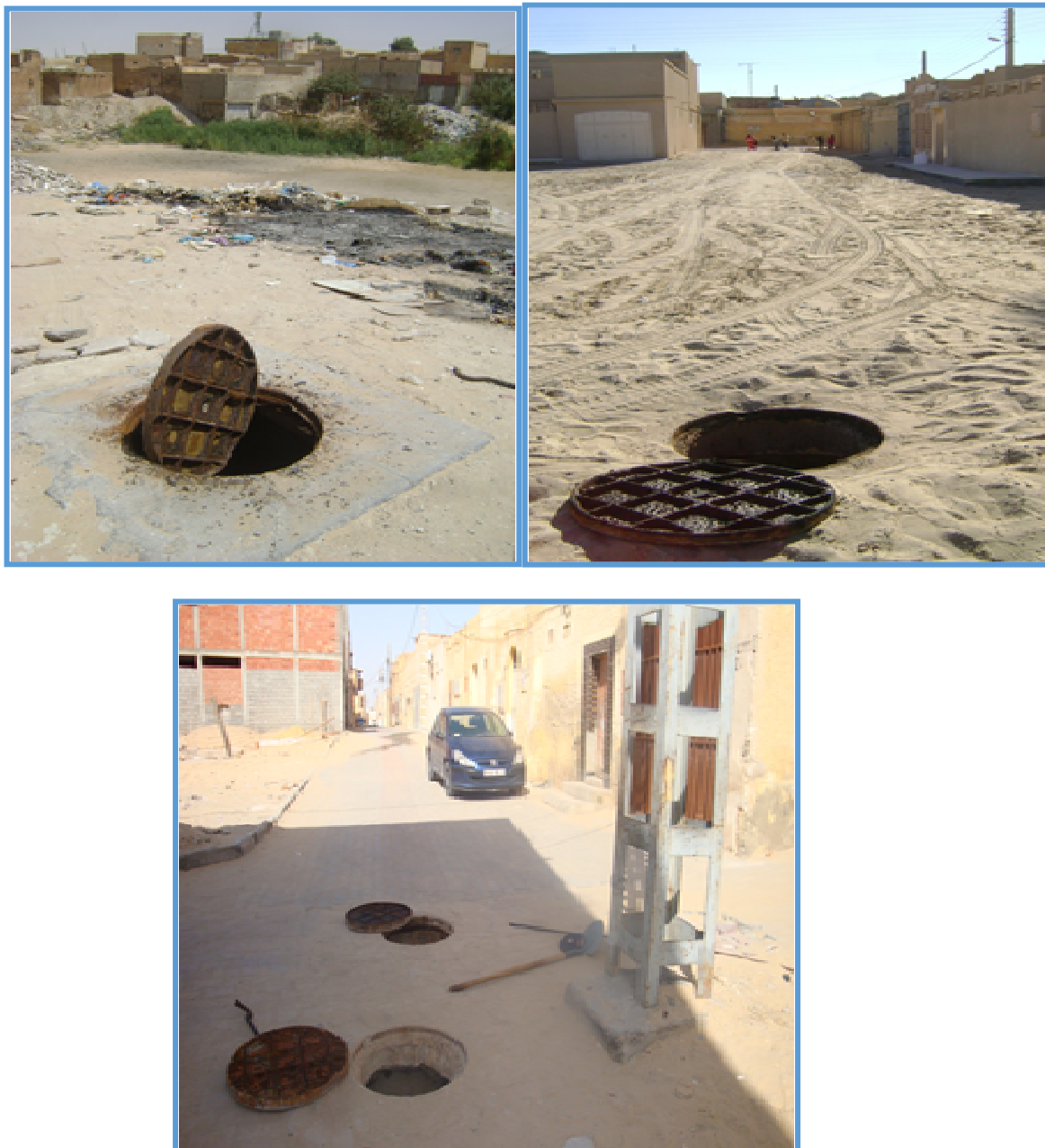
Photo IV.5 : Fermeture des trous des tampons.
