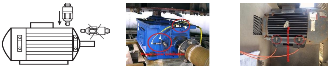
Figure I.27: Montage du capteur du vibratoire sur le moteur asynchrone [IFM][SW21]
