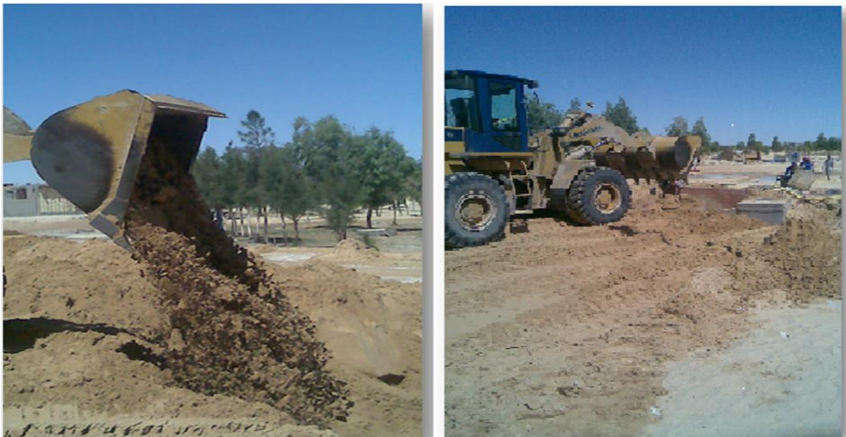
Photo VIII -3 : Remblaiement des tranchées.
