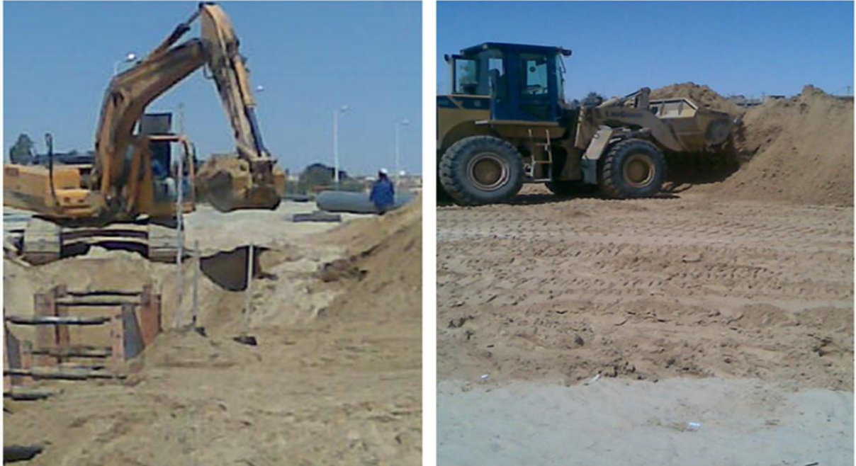
Photo VIII -2 : Terrassement des tranchées.
