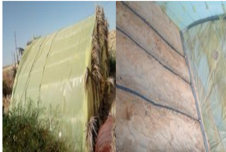
Figure 23. Montage de la serre et installation du système d'irrigation (Originale, 2020)
