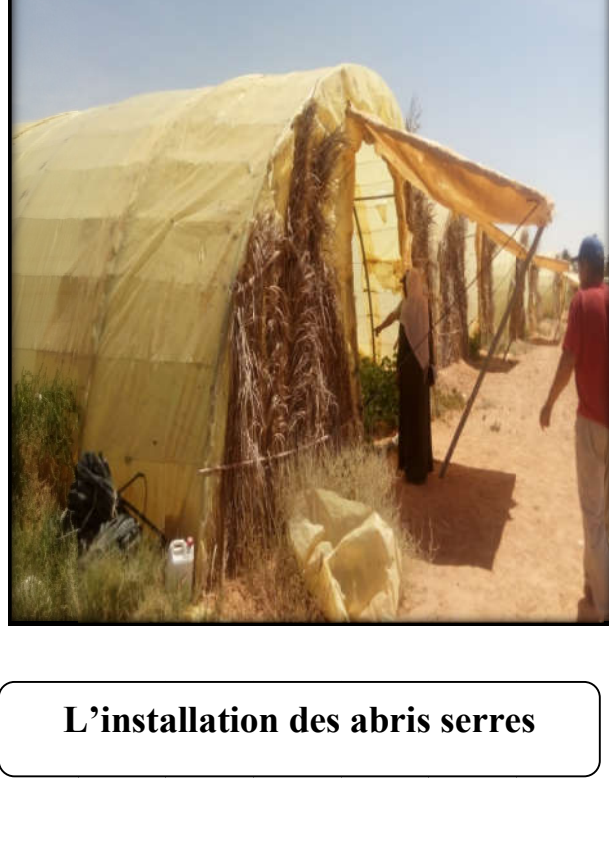
L'installation des abris serres
