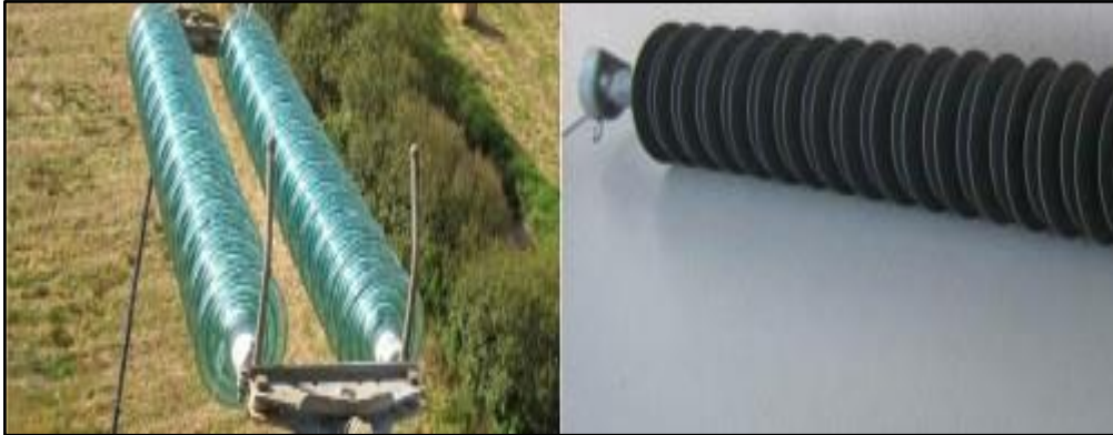
Figure I.7 en verr: isolateurs e trempé et isolateurs rigides
