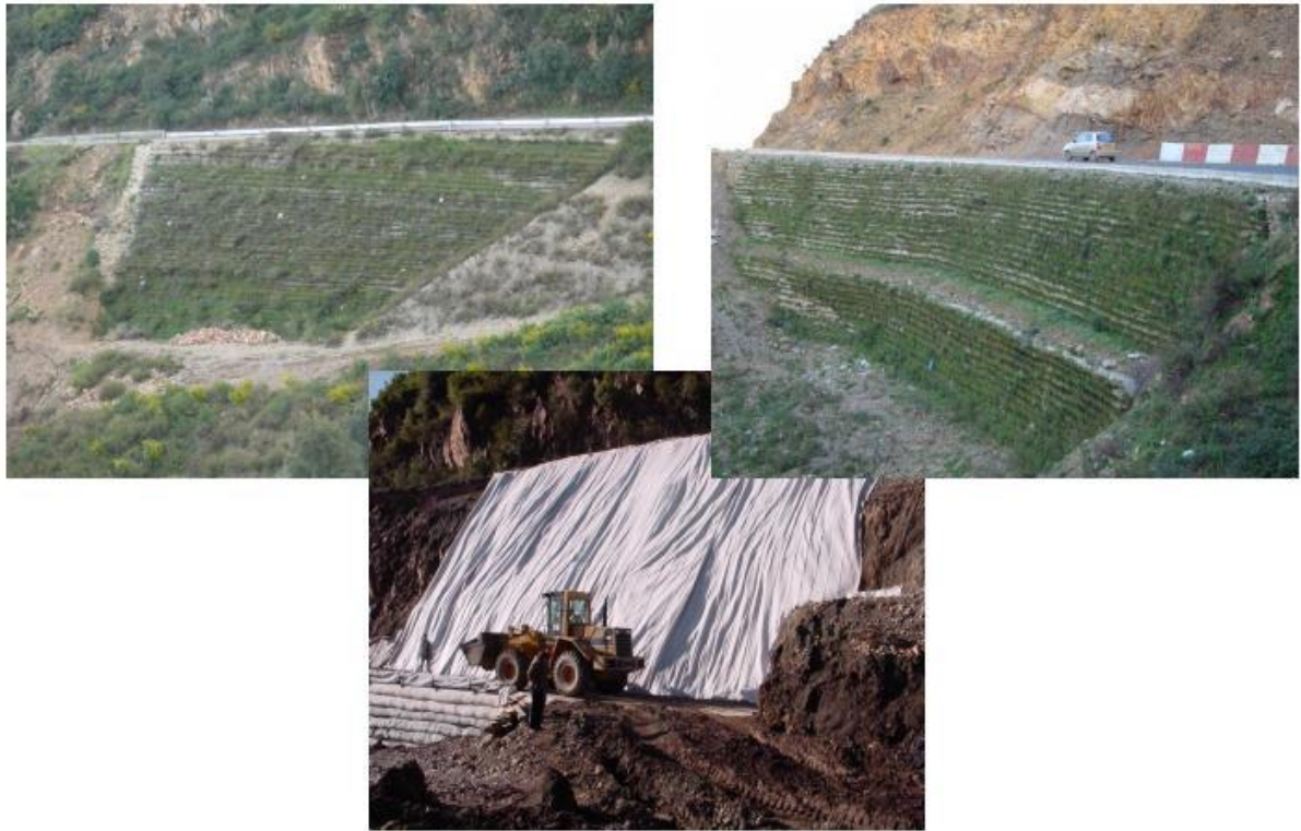
Figure I.10. Traitement d'un glissement de terrain Bejaia[13]
