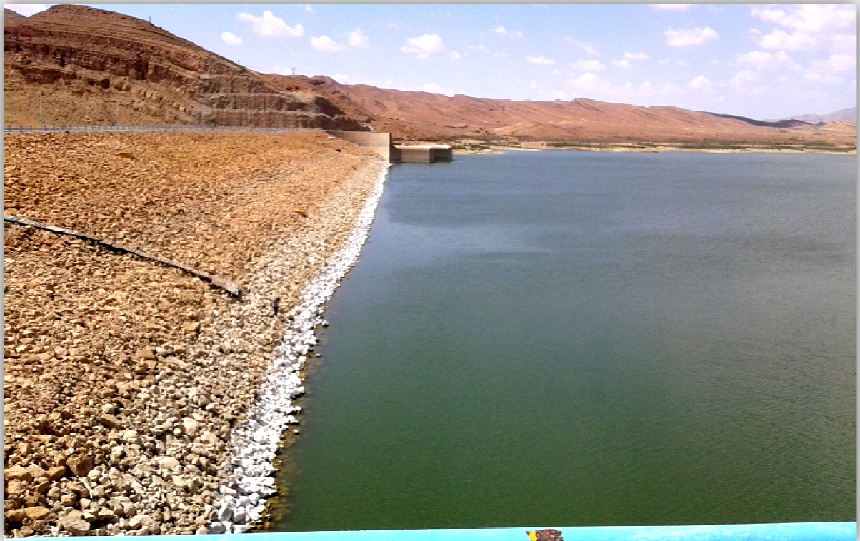
Figure 1. La retenue de barrage de fontaine des gazelles (Laouni et Bettahar ,2017).
