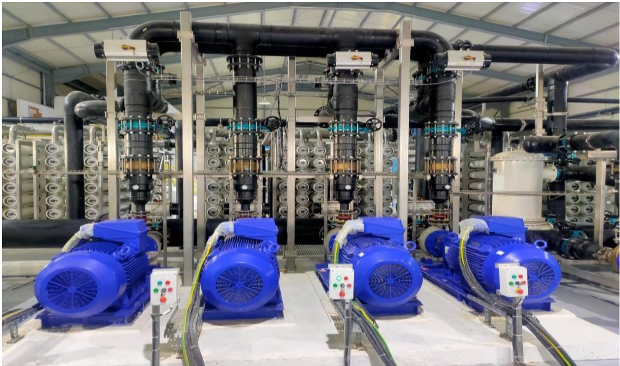
Image II.10: Pompes d'alimentation haut pression
