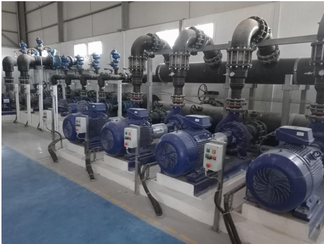
Image II.8: Pompes d'alimentation basse pression
