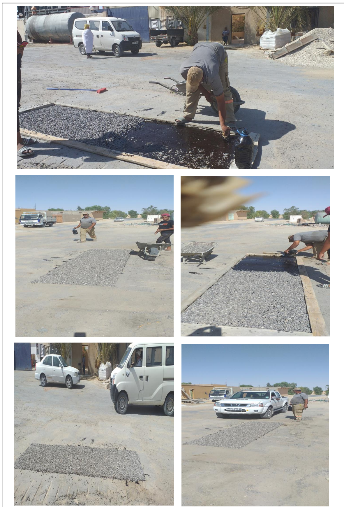
Figure 38 Planche d'essai en enduit superficiel en enduit superficiel avec l'émulsion
