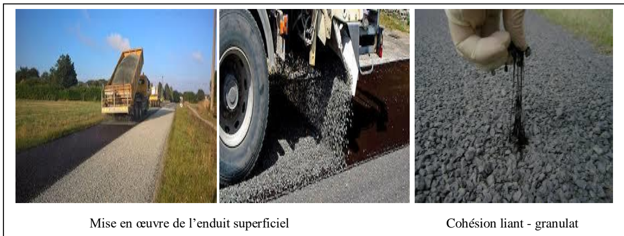
Figure 21 Mise en œuvre de l'enduit superficiel [9]
