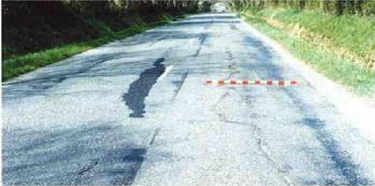
Figure 14 Joint défectueux [3]
