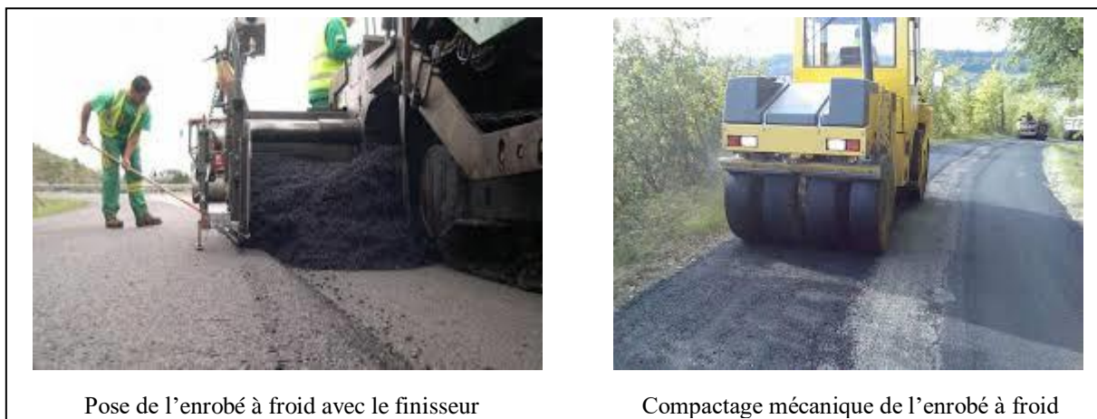
Figure 22 Stockage et pose de l'enrobé à froid à l'émulsion [10]
