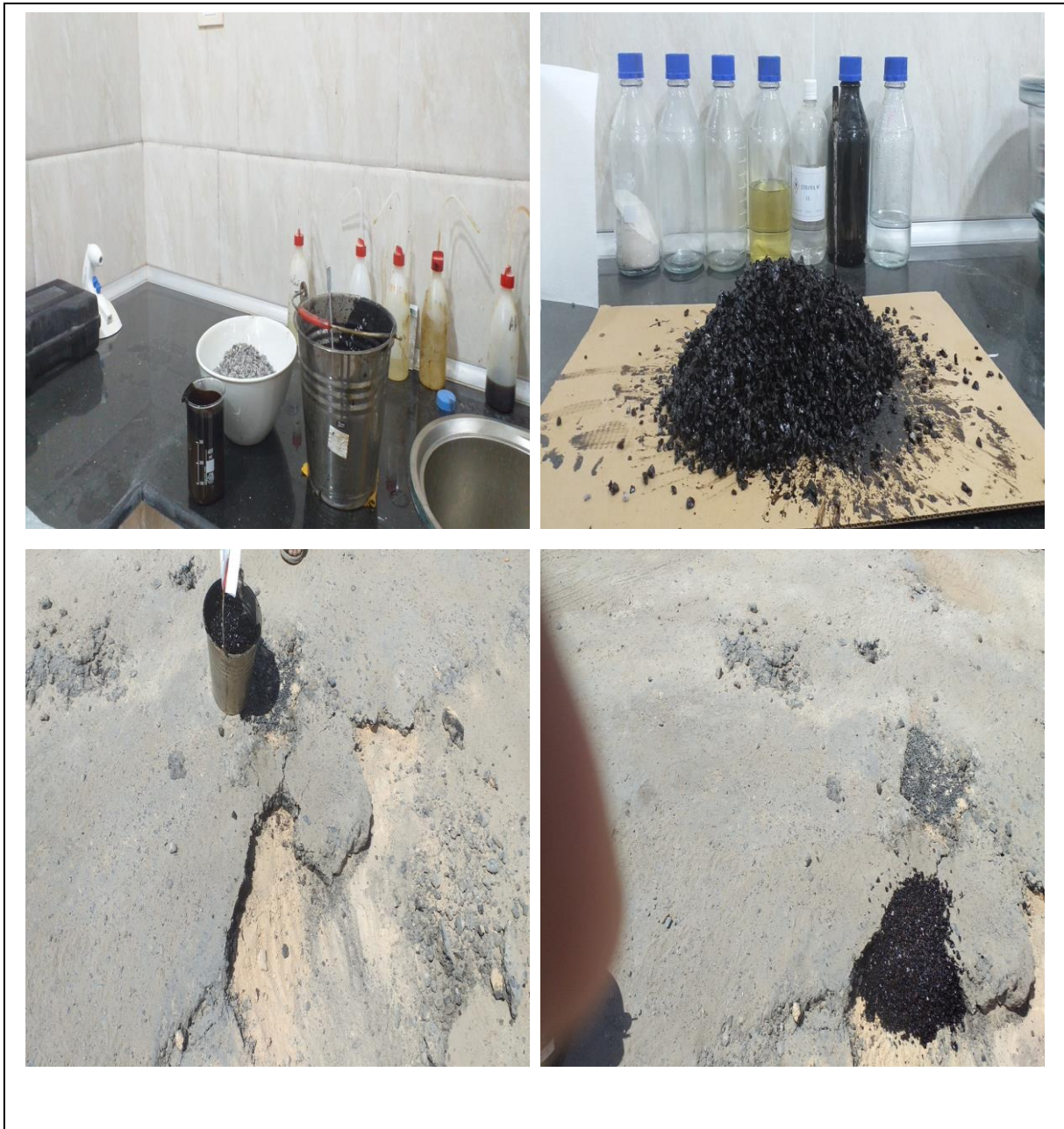
Figure 39 Planche d'essai enrobé à froid stockable avec l'émulsion
