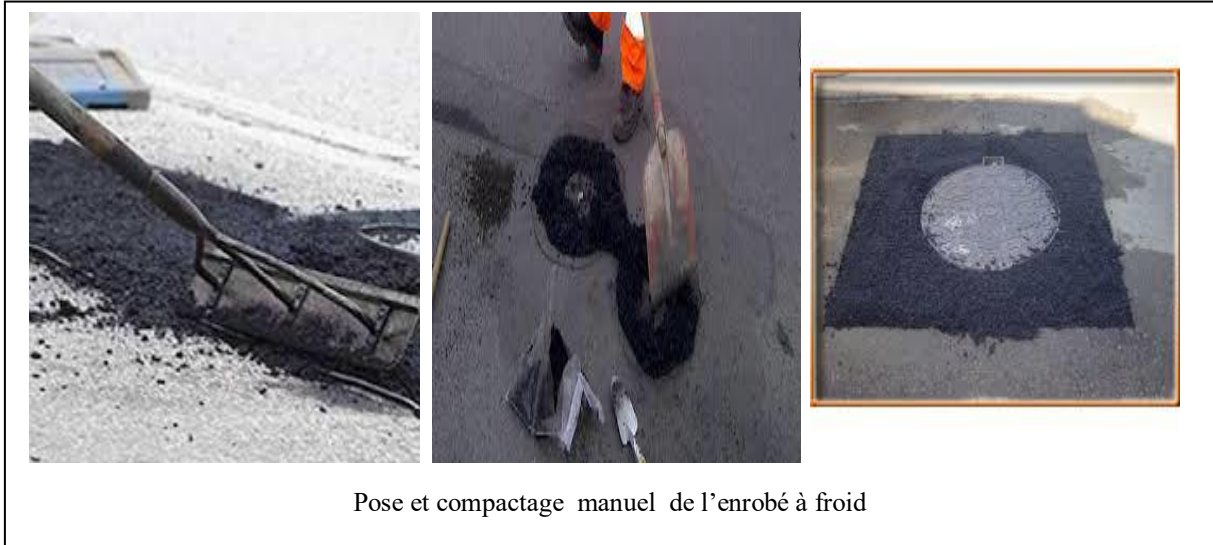
Figure 24 Mise en œuvre et compactage manuel de l'enrobé à froid à l'émulsion [10]
