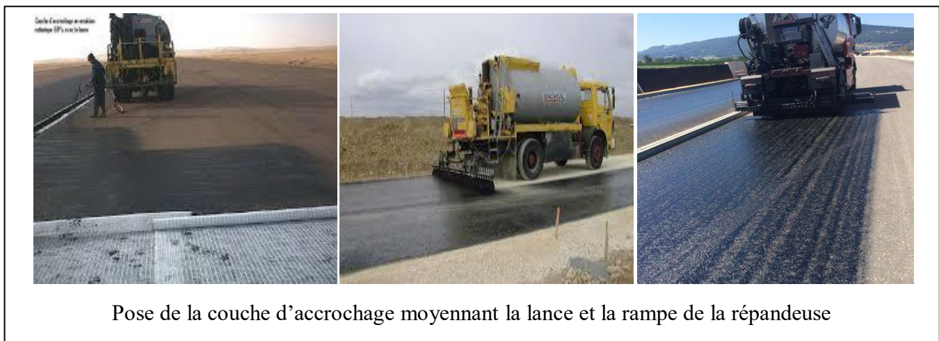
Figure 17 Mise en œuvre de la couche d'accrochage [5]
