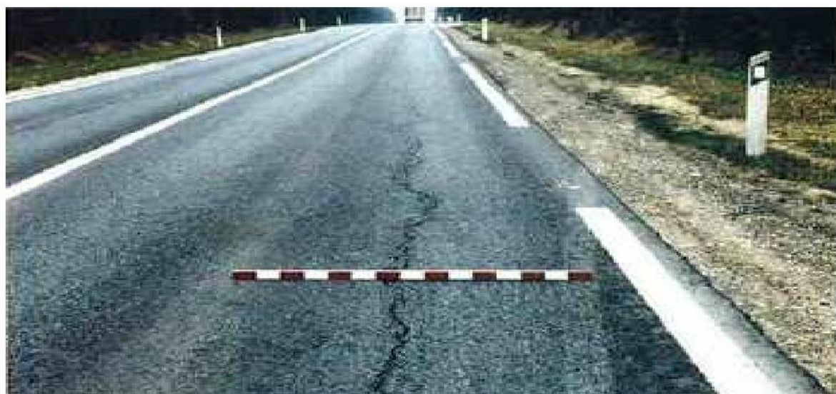
Figure 11 Fissure longitudinale [3]
