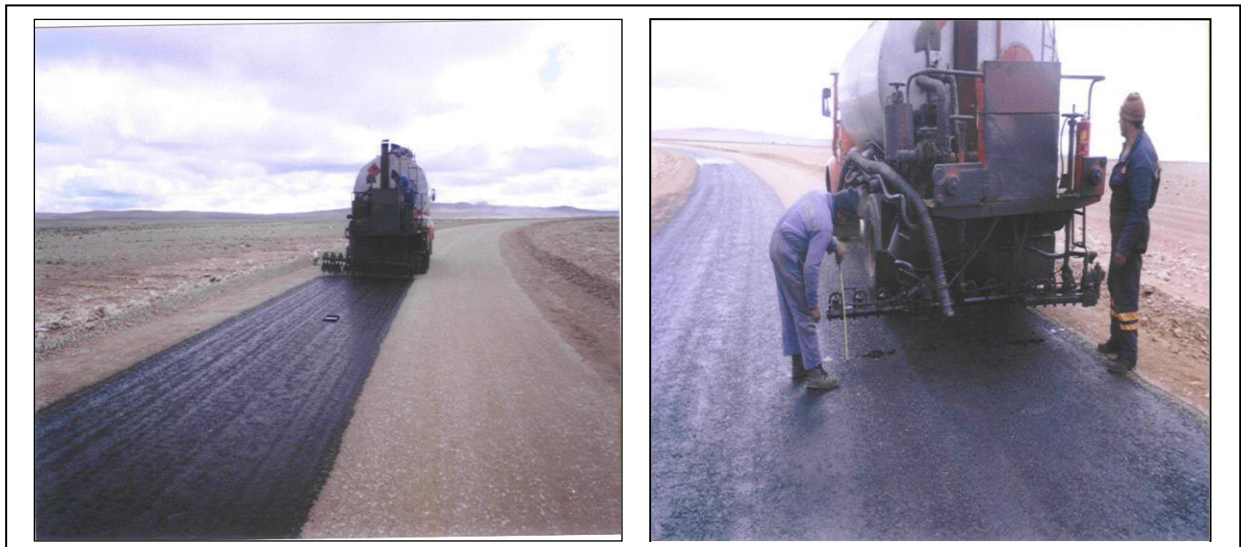
Figure 19 Mise en œuvre de la couche d'imprégnation [7]
