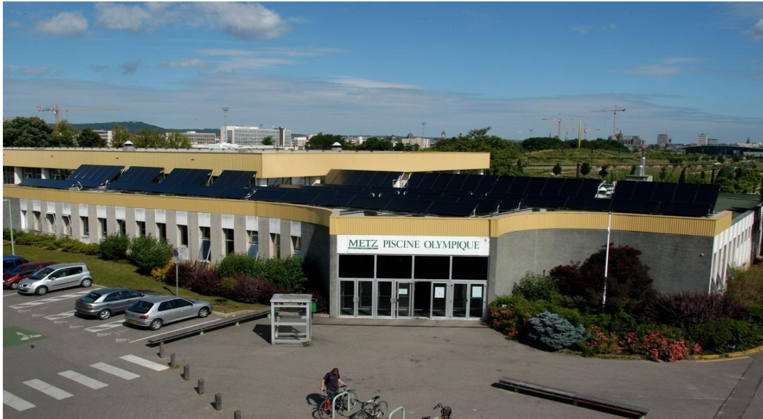
Figure I-4-installation de capteurs thermiques
