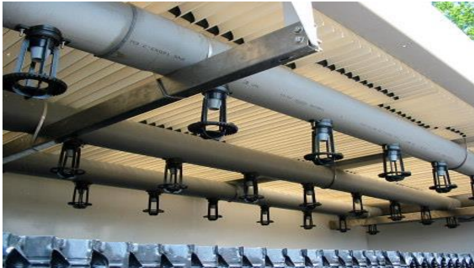
Figure II.17: Schéma d'un système de dispersion du fluide à refroidir [52].
