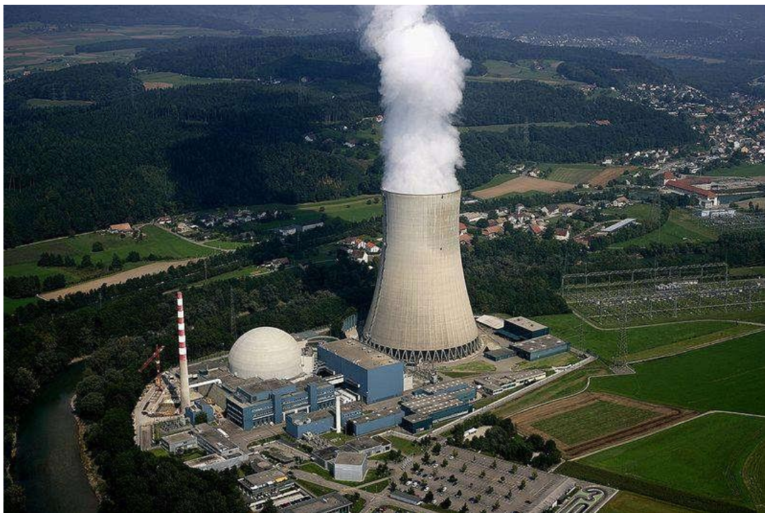
Figure II.2 : Photo d'une tour de refroidissement dans une centrale thermique [35].
