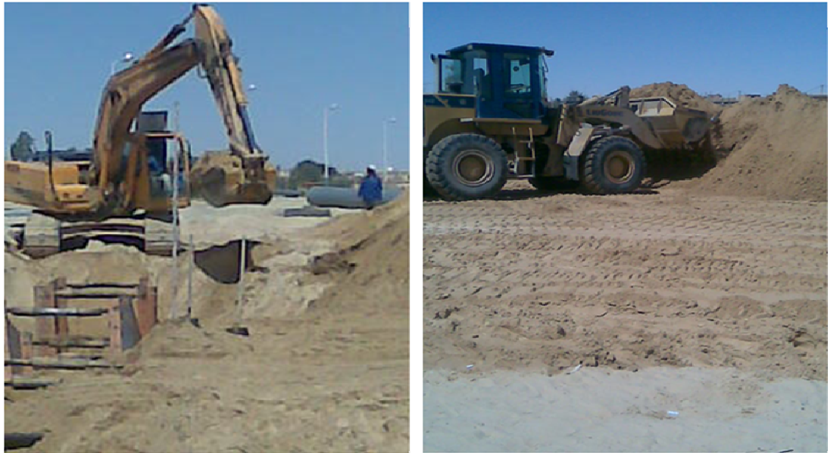
Photo VI -2 : Terrassement des tranchées.
