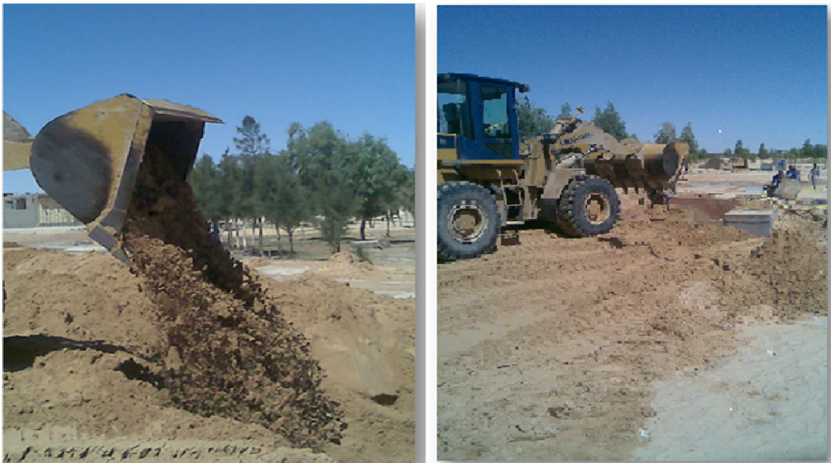
Photo VI -3 : Remblaiement des tranchées.
