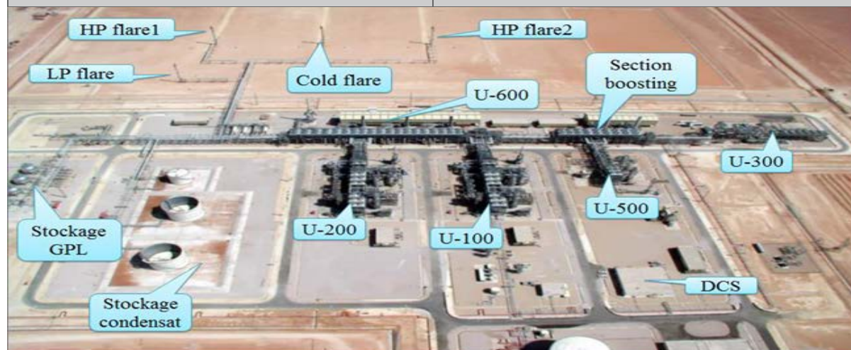
Figure 2 : Usine de Traitement de Gaz Ohanet
