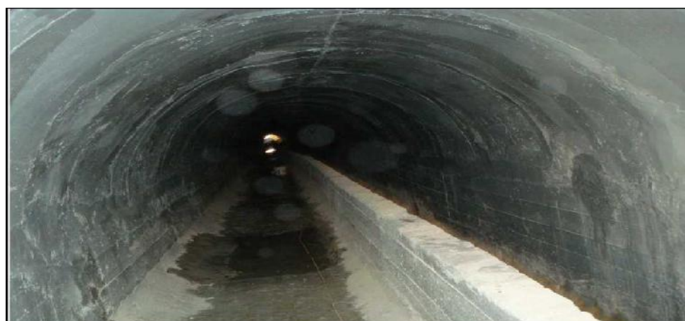
photo 3.2 : la 3eme tranche de la galerie visitable de Touggourt[7]
