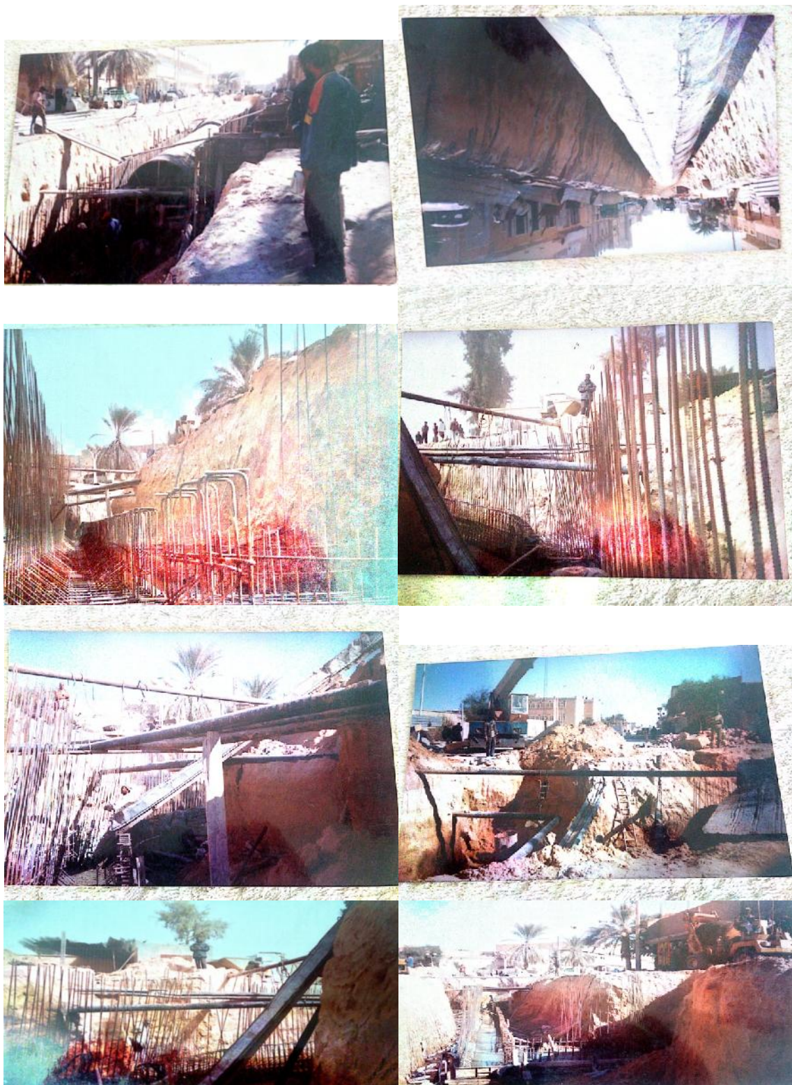
Photos au moment de la réalisation de la galerie visitable de Touggourt
