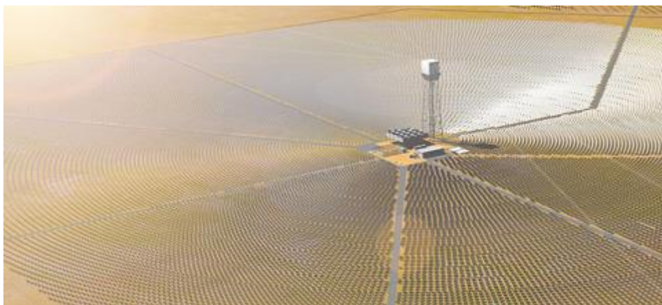
Fig II.4 Centrale à tour 125 MW de Solaire brillant.
