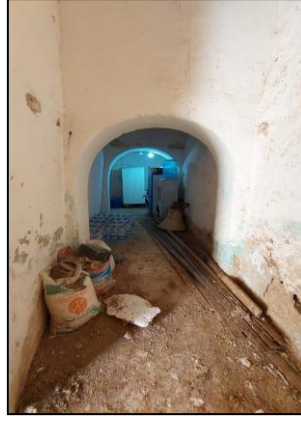
الصورة رقم 03: سقيفة المدخل الخلفي لبيت صلاة عبد الله المغراوي
