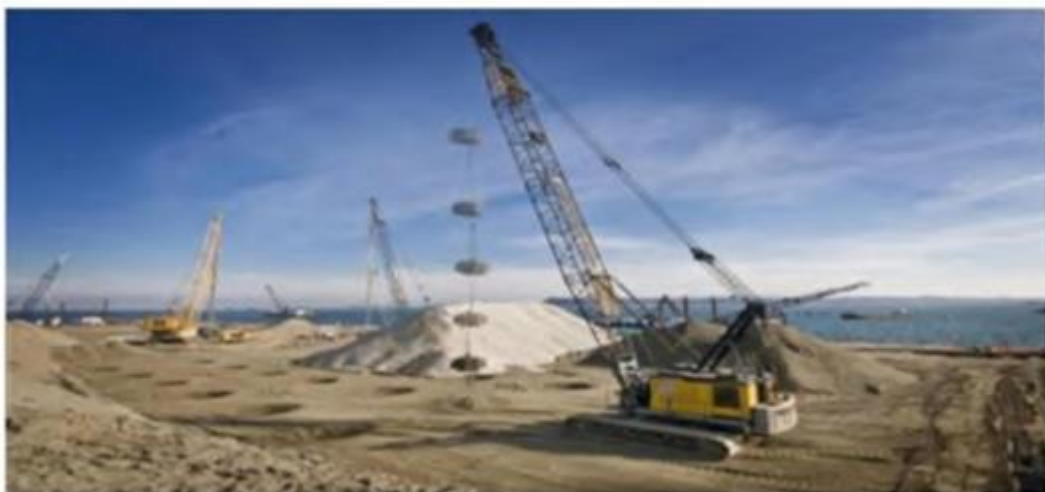
Figure I.21. Chantier d'un compactage dynamique profond. [3]
