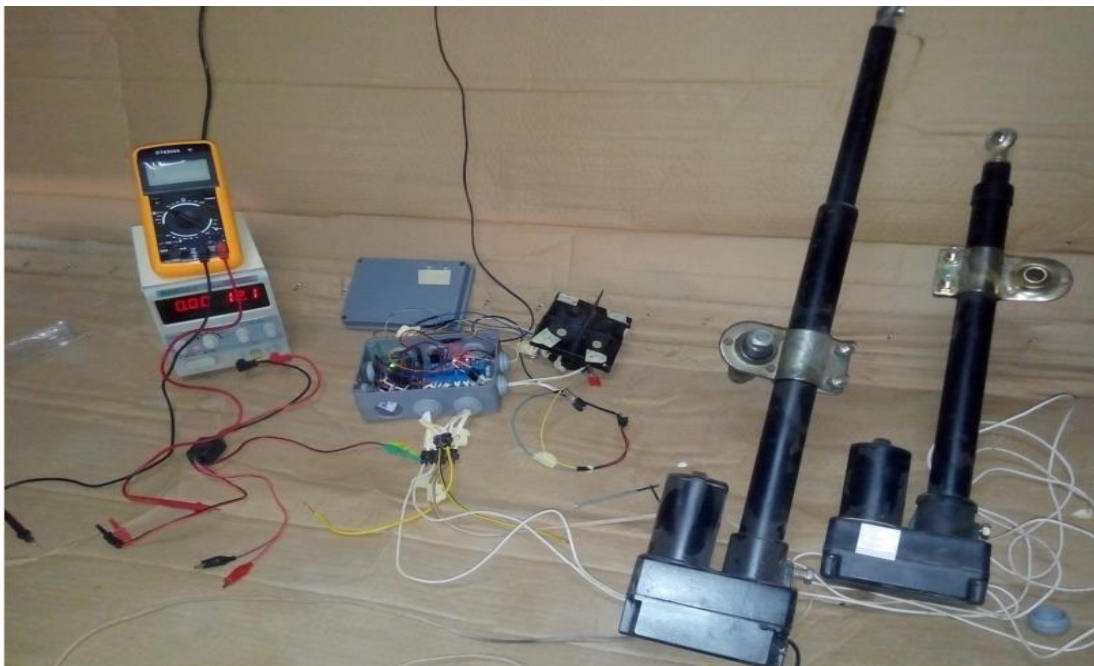
Figure.III.12. Photo de Réalisation du circuit électrique du système poursuite en à vide.
