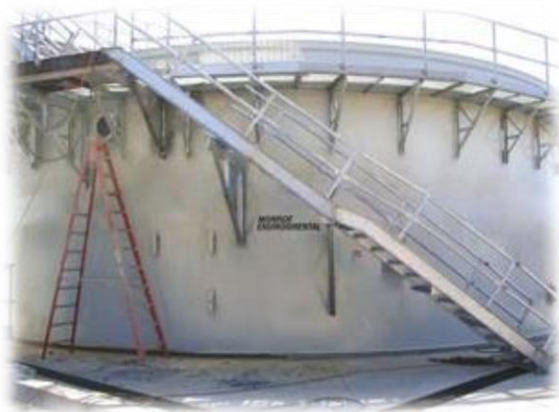
Figure.III.1: Séparateur d'huile circulaire de type API [62]
