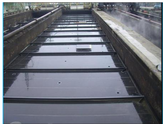
Figure.III.2: Séparateur d'huile rectangulaire type API [63]
