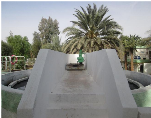
Photo.07: Epaisseur de boues.
