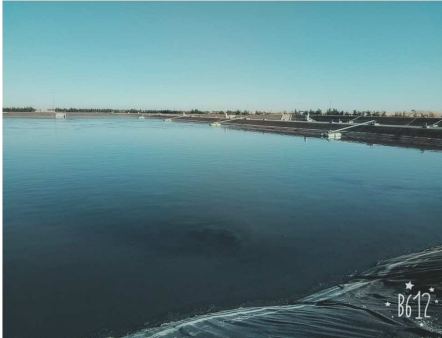
Photo IV.5. Lagune aérée (station de Hassani Abdelkrim).
