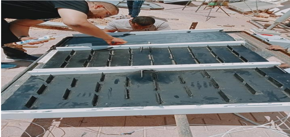
Photo III.15: Mettre la silicone sur tous les côtés.
