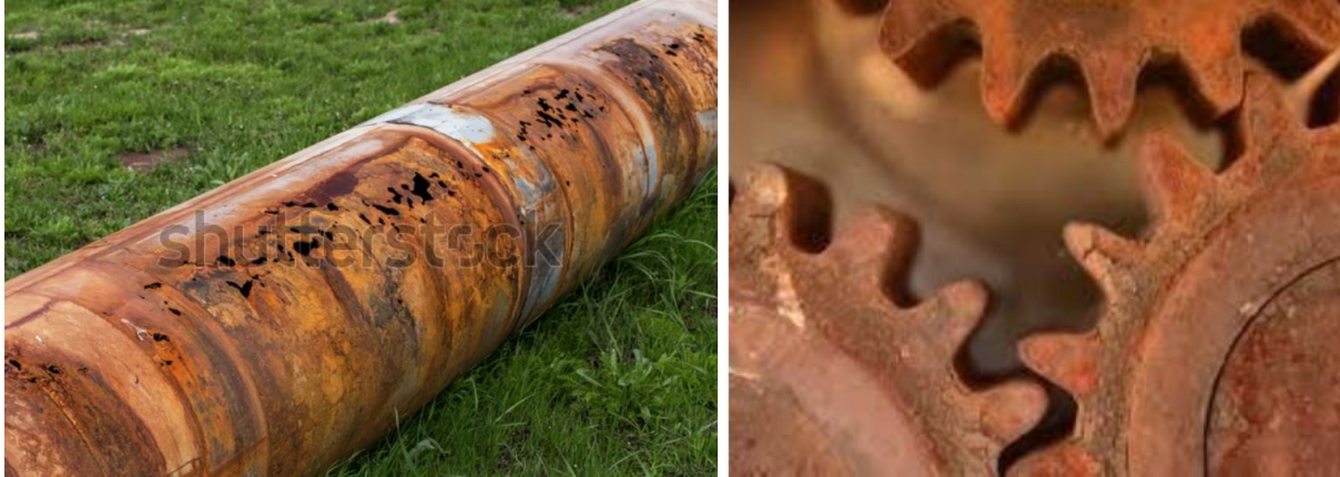
Figure 6 : Exemple de corrosion généralisée
