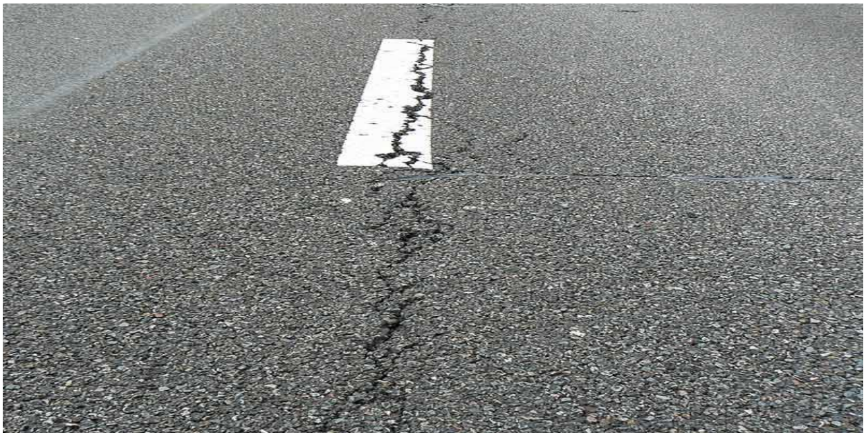
Figure 2.2 : Fissures longitudinales
