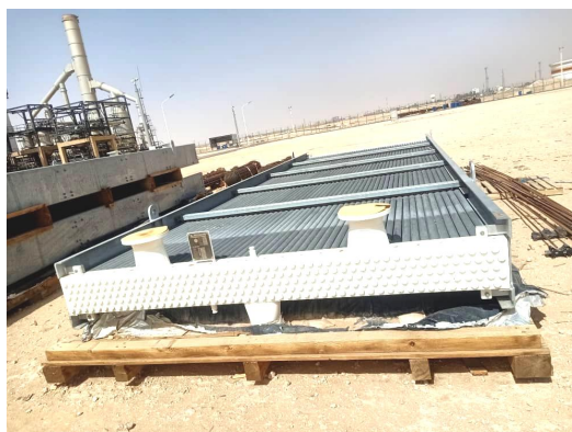
Figure (III.2) : Cellule Aéroréfrigérants installée à la raffinerie RHM2
