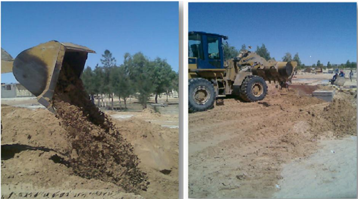
V.3 : Remblaiement des tranchées.
