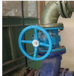
Photo I.5. Vanne de régulation du débit.
