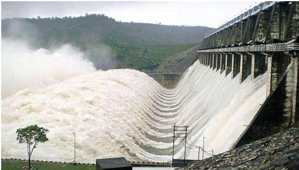
Photo I.1 : le ressaut hydraulique dans la nature
