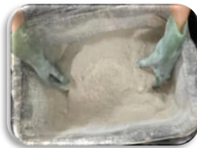
Figure.II.11. Mélanger les matières sèches
