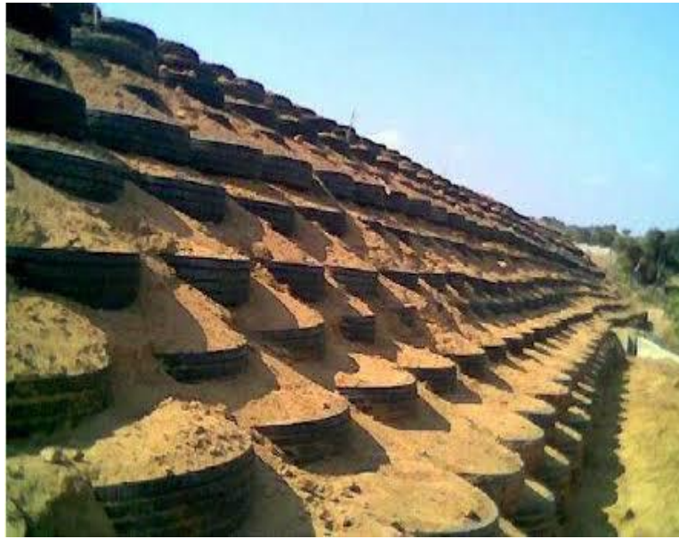
Figure I.8. Chantier expérimental Pneusol à Bou-Smail [18].
