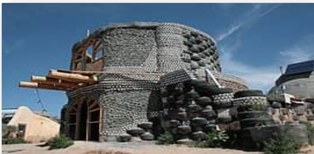
FigureI.6. Exemples concrets d'utilisation de déchets de caoutchouc dans la construction.
