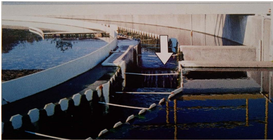
Figure03: Traitement primaire des eaux usées.Les eaux usées sont pompées dans un bassin (à gauche),dans lequel les matières solides sédimenter. Lorsque le niveau de l'eau s'élève, le trop-plein est évacué au travers de grilles vers les niveaux inférieure. Les eaux usées, désormais dépourvues de solides, pénètrent dans les déversoirs(flèche) et sont alors pompées vers les installatinos de traitement secondaire( Michael Madigan et John Martinko,2007 )
