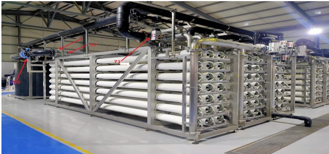
image 10: le placement des membranes de la station par étage de L'osmose inverse
