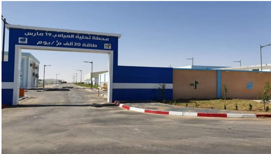
Image 2: La station de déminéralisation 19 mars
