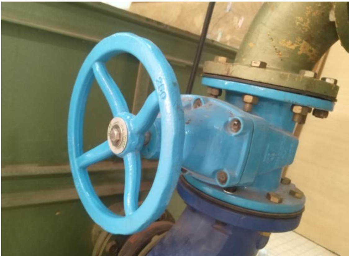
Figure 2.4: Photographie de La vanne de régulation du débit(Laboratoire Université Ouargla).
