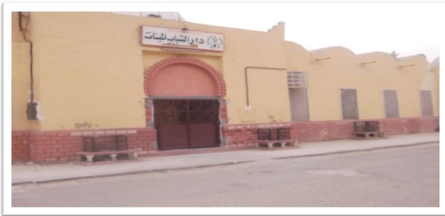
صور لمبنى المدرسة الفرنسية الخاصة بالأروبيين بتقرت
