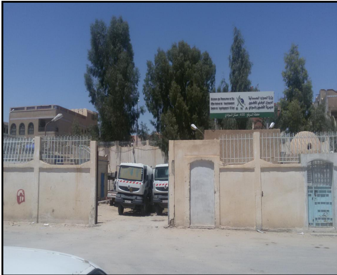
Photos N° II-29 : station de relevage SR 400 Logts.
