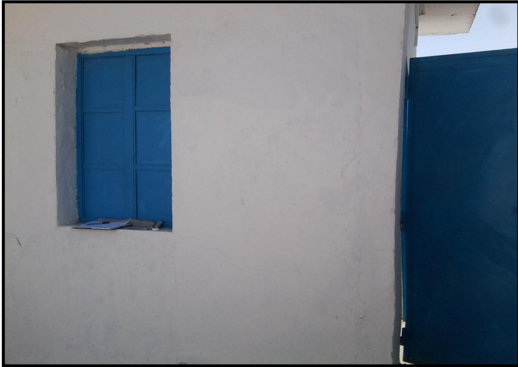
Photos N° II-13 : Loge gardien de la station relevage SR04.
