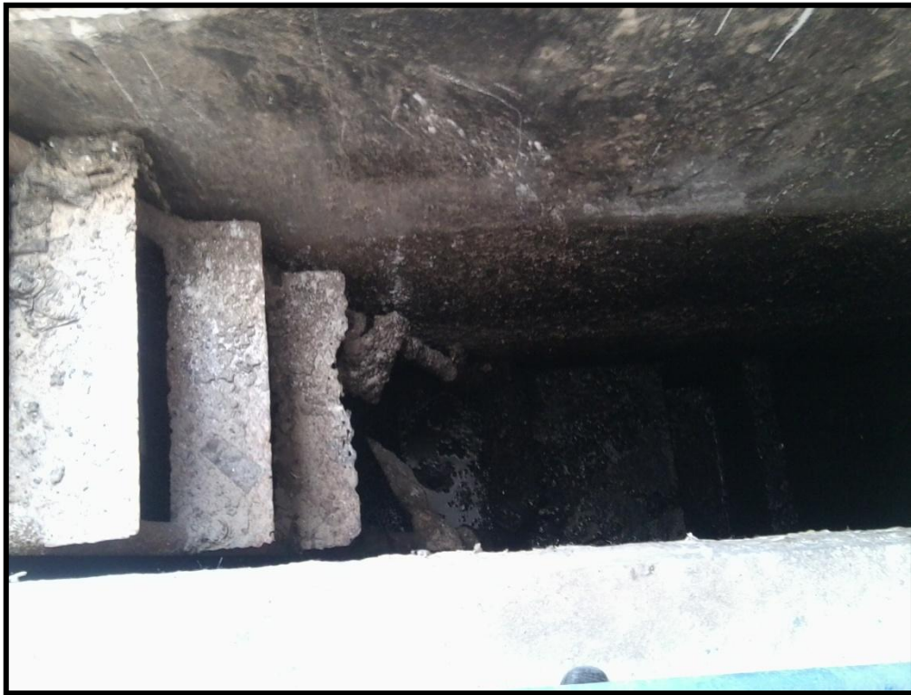
Photos N° II-05 : Une échelle du bôme de stockage de la station relevage SR03.
