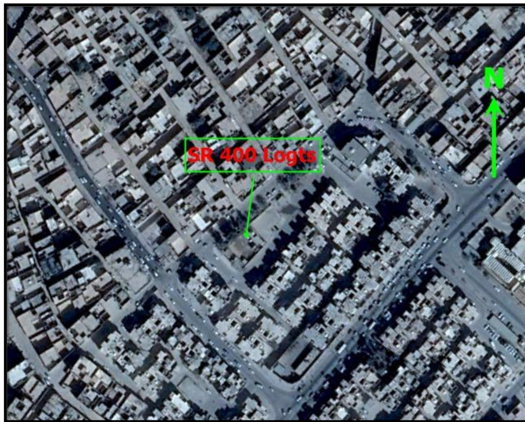
Figure N° II-09 : situation géographique de la station de relevage SR 400 Logts.
