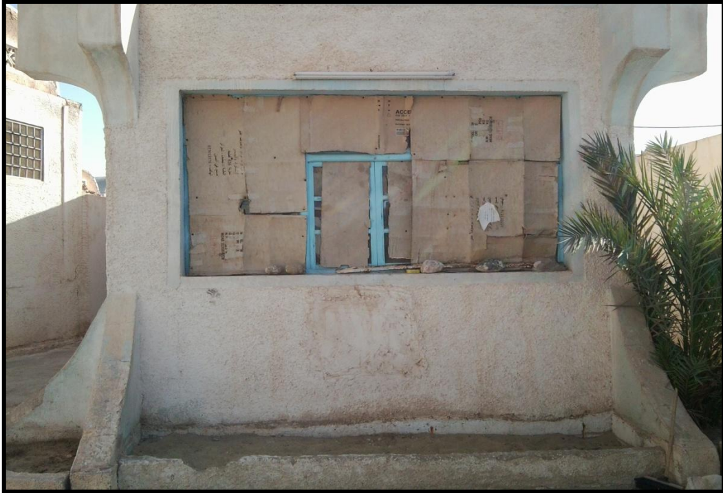
Photos N° II-23 : Loge gardien de la station de relevage SR06.
