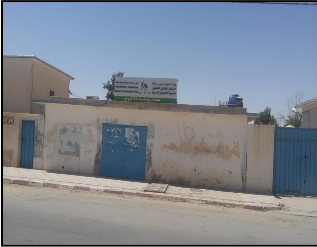
Photos N° II-12 : station de relevage SR04.
