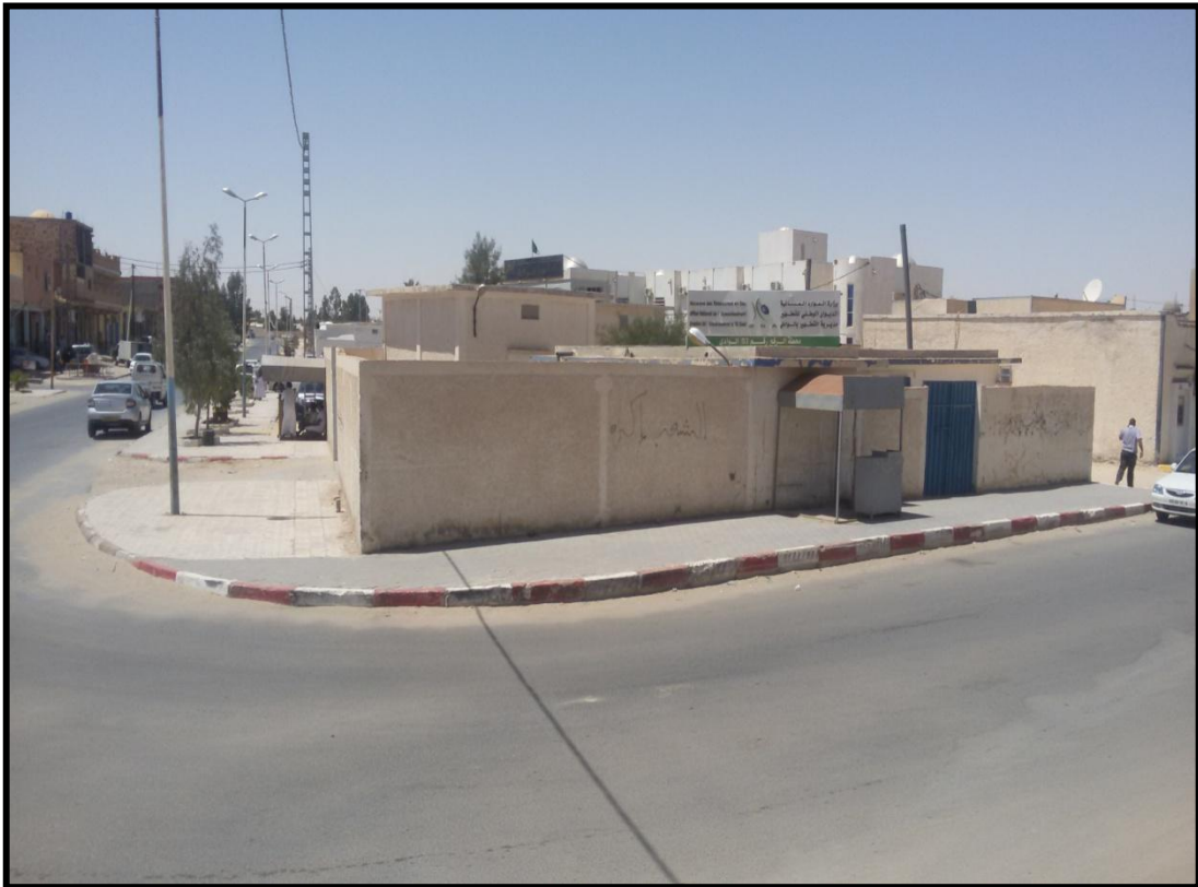
Photos N° II-01 : station de relevage SR03.
