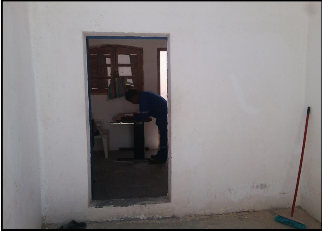
Photos N° II-02 : Loge gardien de la station relevage SR03.
