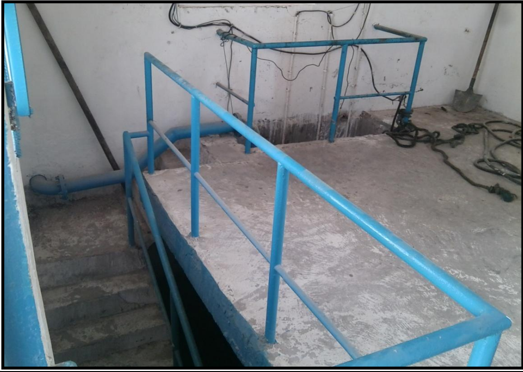
Photos N° II-16 : Un escalier du bôme de stockage de la station relevage SR04.
