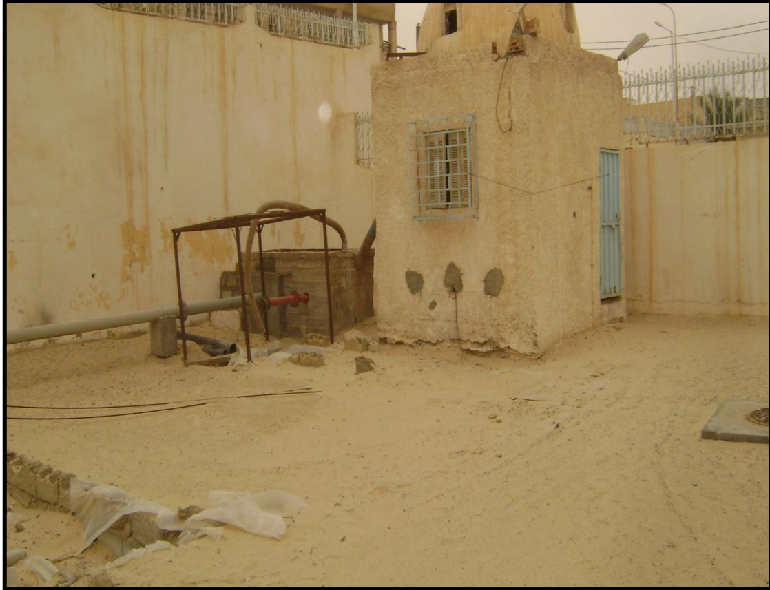
Photos N° II-30 : Loge gardien de la station de relevage SR 400Logts.
