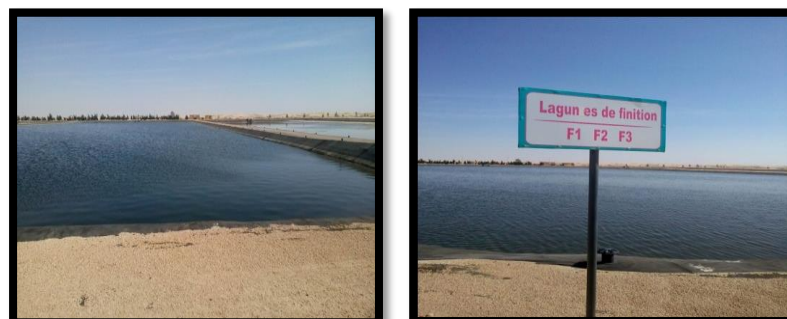
Figure 27 : Lagune de finition.
