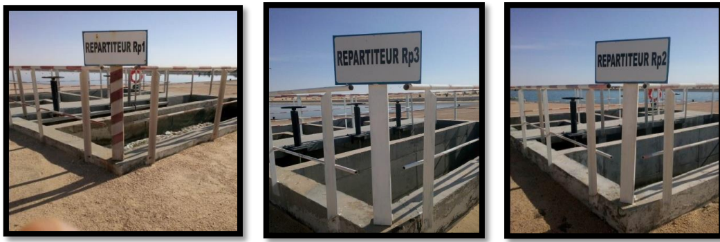
Figure 24 : Répartiteur vers les bassins d'aération.
