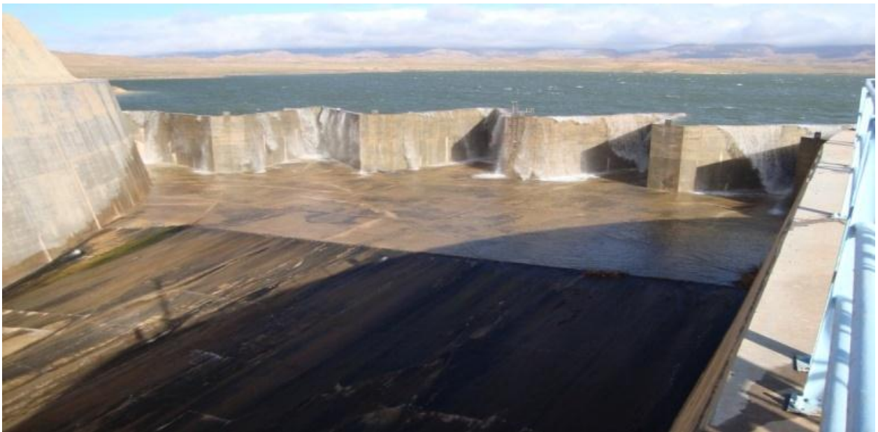
Figure II.12:Evacuateur de crues[17].
