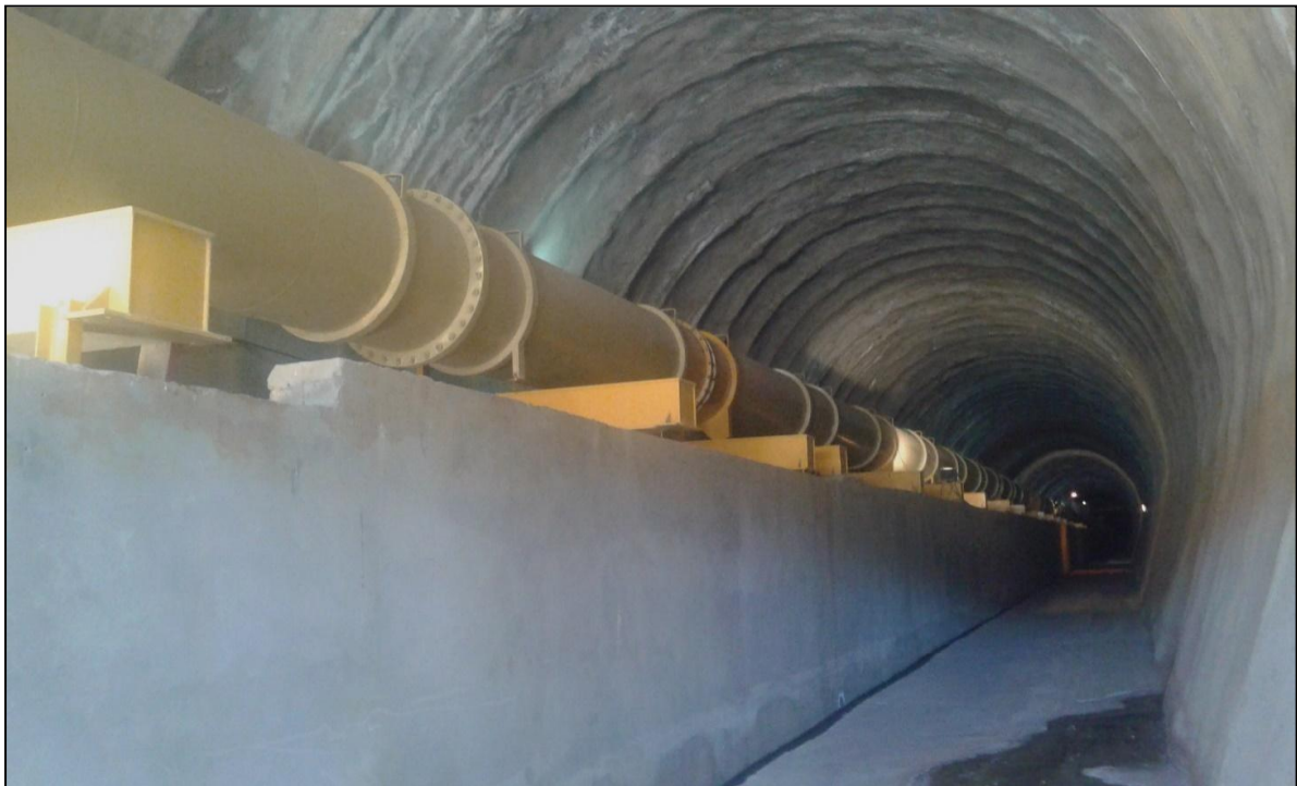
Figure II.14: Tunnel de la vidange de fond[17].
