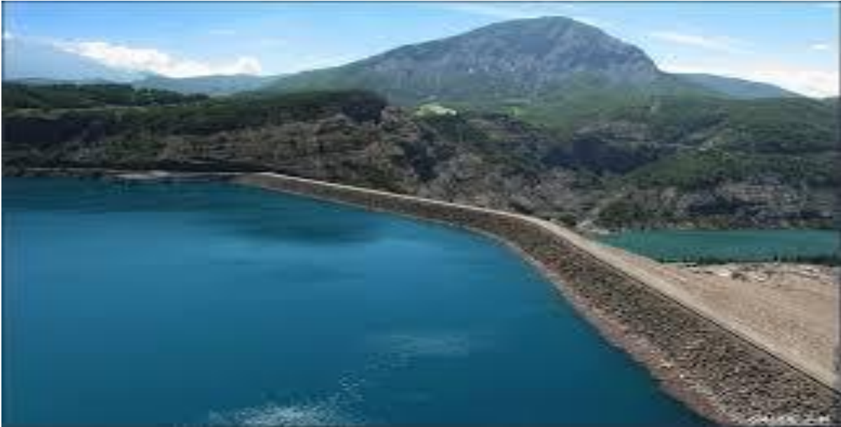
Figure I.6 : Barrage en terre
