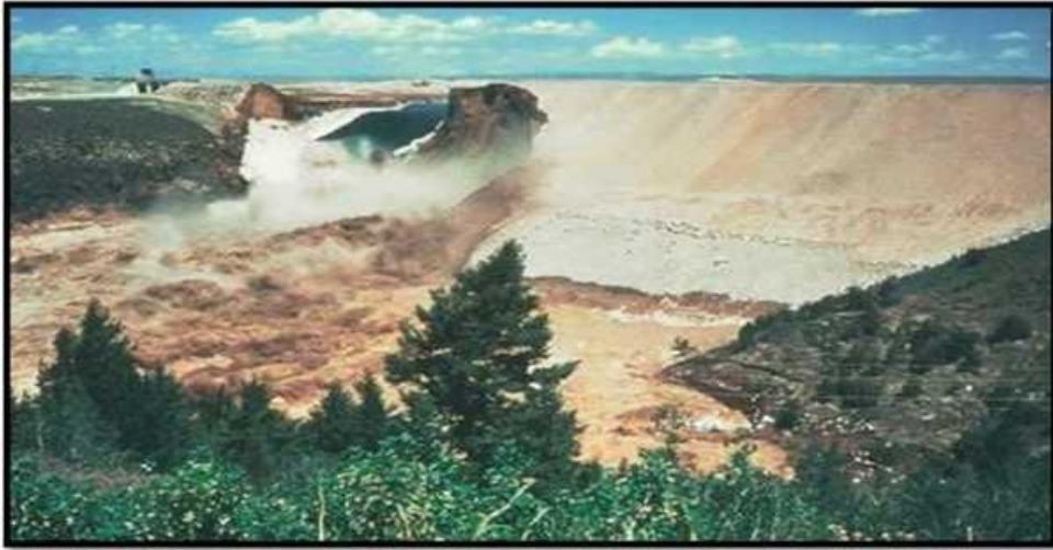
Figure I.9: Rupture du barrage de Teton
