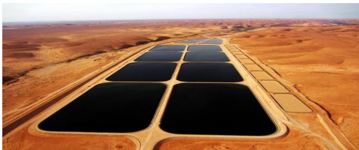
Figure 11: Station d'épuration de Ghardaïa lagunage Naturel (HAMMADI B, 2017).
