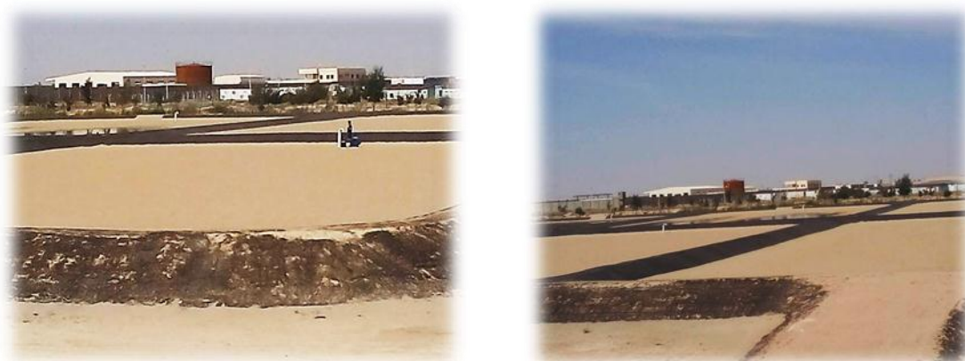
Figure 26: Lit de séchage des boues.
