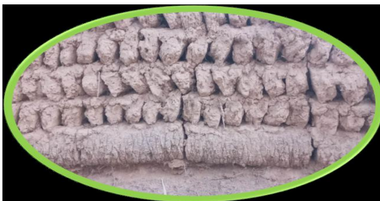
Figure 37: Stipes de palmier sous les murs (Photos Originale)(Mokrani ,2022)
