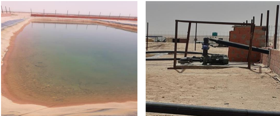
Figure 16 : le bassin et la pompe utilisée pour irrigation.
