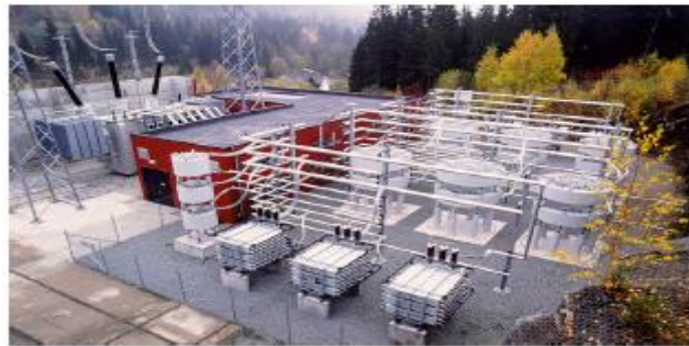
Figure (I.4) : Schéma d'un compensateur synchrone statique SVC
