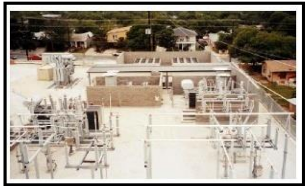
Figure (I.9) : Schéma d'un compensateur statique STATCOM
